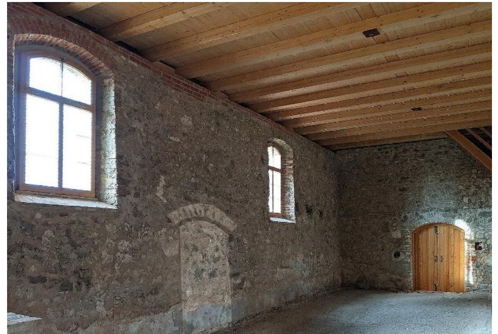
Die Kirche nach der Renovierung innen. Man erkennt an bewitterten Bogensteinen und Mauerschlitzen noch das vermauerte Südportal des Mittelalters (hier optisch hervorgehoben).
