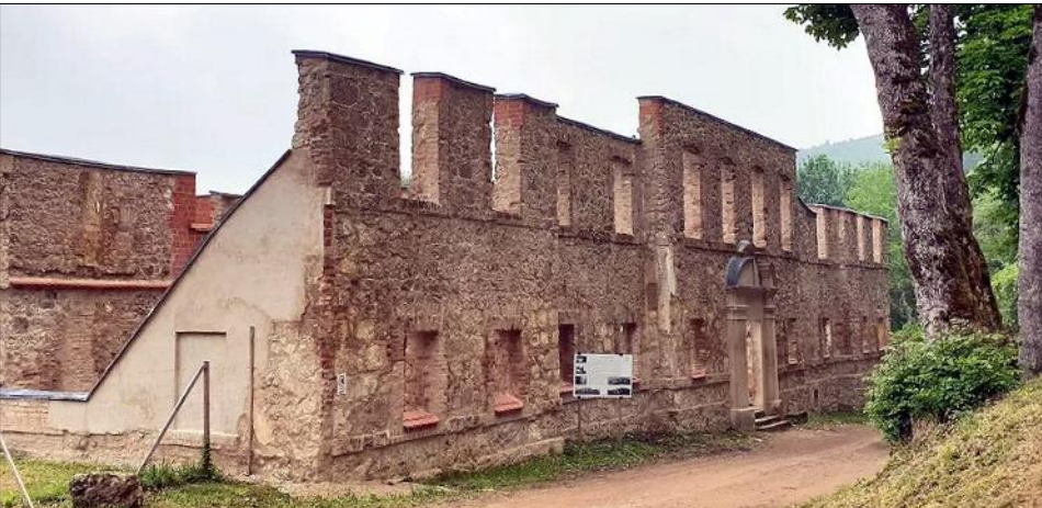
Die Nordfassade des Schlosses (mit Mittelrisalit) nach der Instandsetzung.
