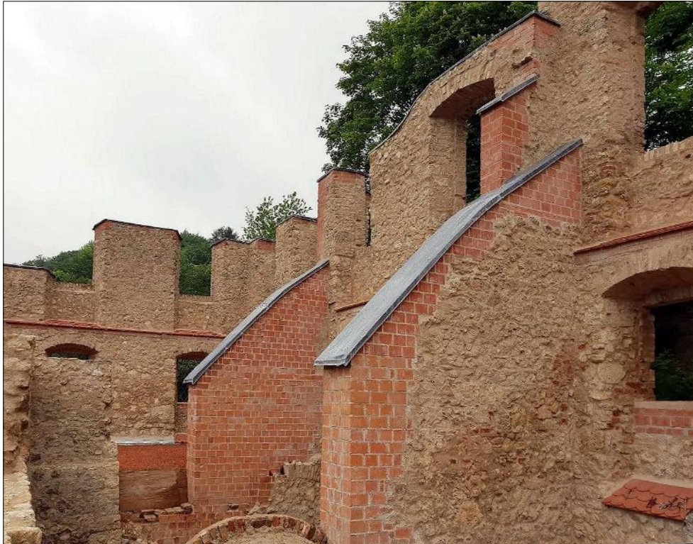
Die restaurierten Schlossmauern innen.
